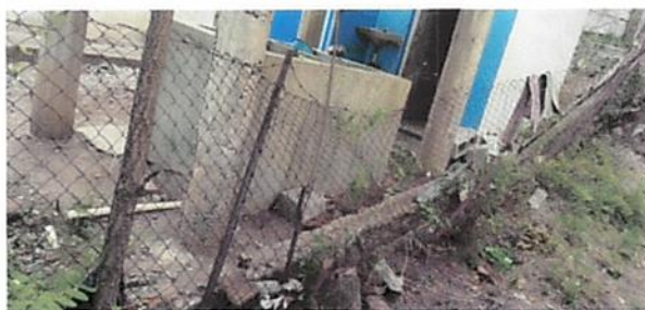
Foto 5: Reposición de malla de circulado perimetral.
