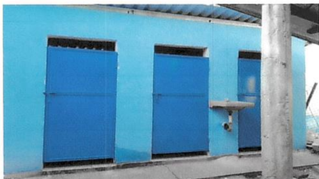
Foto 3: Mantenimiento de 3 baños y un lavamanos.
