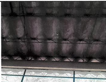
Foto1: Sustrucción de techo y estructura metálica.
