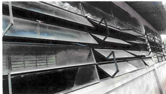
Foto 2: Instalación de ventanas de PVC.
