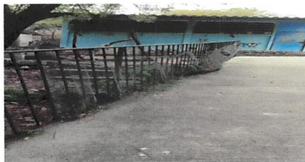
Foto 6: Colocación de malla fina en pasio de entrada principal.
